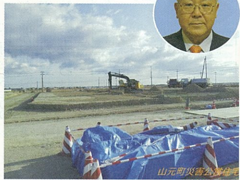
まだ難航している災害公営住宅建設
