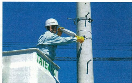
交換工事を行なう組合員
